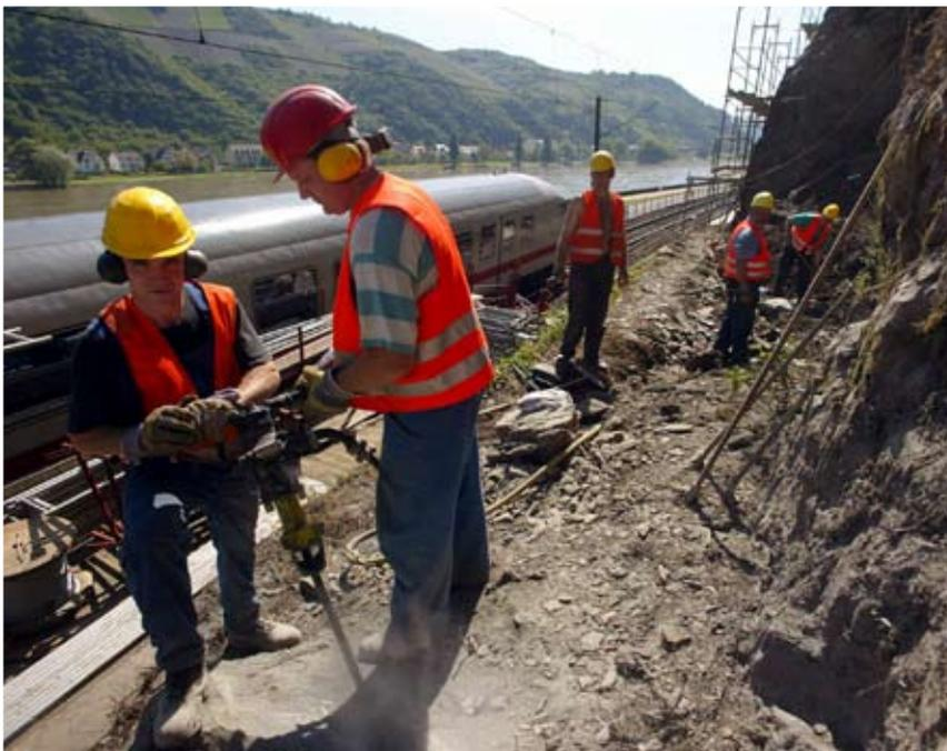
Die Mittelrheintalstrecke muss aufwändig gesichert werden. Die Erschütterungen der Züge begünstigen Steinschlag und Hangrutsch.
