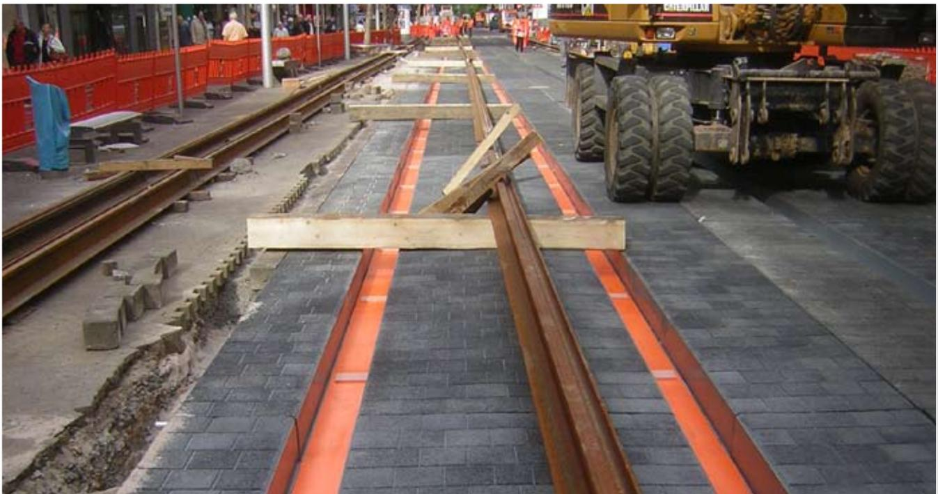
*Festes Fahrbahnssystem mit kontinuierlicher, elastischer Schienenlagerung Innenstadt Karlsruhe. Auch für die Vollbahn mit ihren höheren Achslasten im Güterverkehr gibt es erschütterungsarme Lösungen.*
