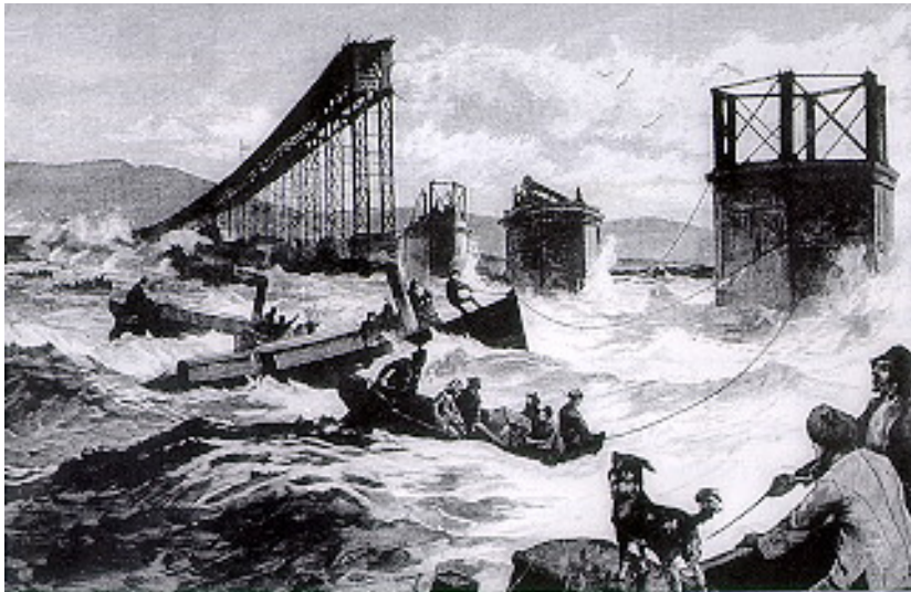
Bild 1: "Die Brücke am Tay". In einer Sturmnacht des Jahres 1879 stürzte sie samt Eisenbahnzug in den Fluß
