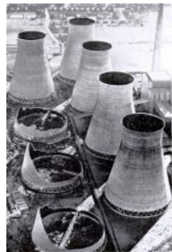
Bild 2: Spektakulärer Sturmschaden: Einsturz von drei Kühltürmen in Ferrybridge, England, 1965.
