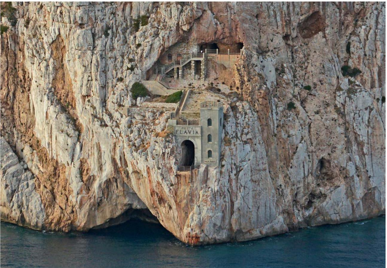
Abb.192: Die Schiffsverladestelle Porto Flavia, die 1924 in Betrieb genommen wurde, befindet sich in der Nähe des ehemaligen Bergarbeiterdorfes Masua. Blei- und Zinkerze wurden über Förderbänder oder mit Hilfe einer Lorenbahn durch zwei übereinanderliegende, 600 m lange Schächte zur Anlage gebracht und von dort (16 bzw. 37 m über dem Meeresspiegel) direkt in den Kielraum der Schiffe verladen.
