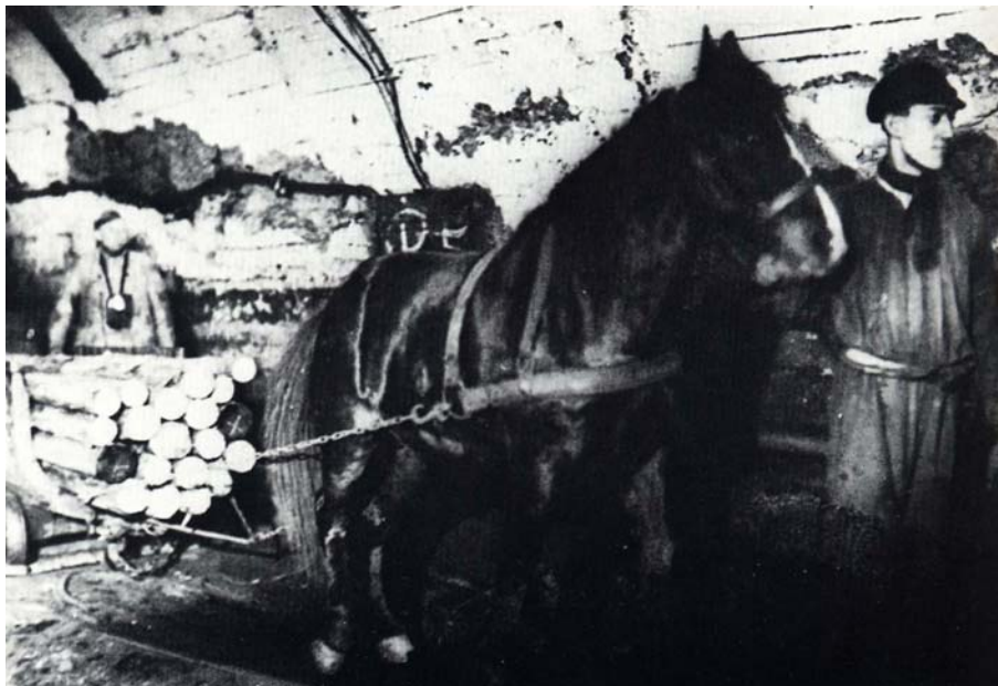
Abb. 1: Transport von Grubenholz auf der Zeche Hannover um 1935
