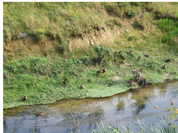
Abb. 9: Abbruch 2 bei Niedrigwasser
