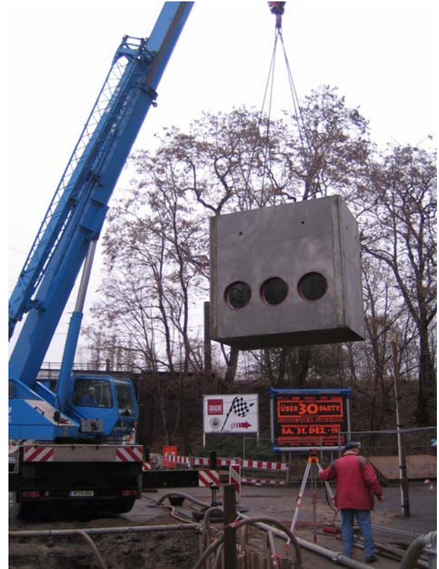
Bild 1: Eindruck von einer Baustelle
