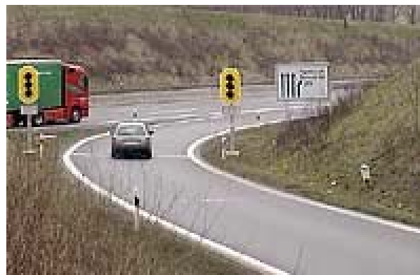
Bild 1: Zuflussregulierungsanlage (Quelle: Straßen.NRW)
