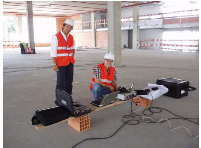
Bild 1: Messungen auf einer Baustelle in Portugal
