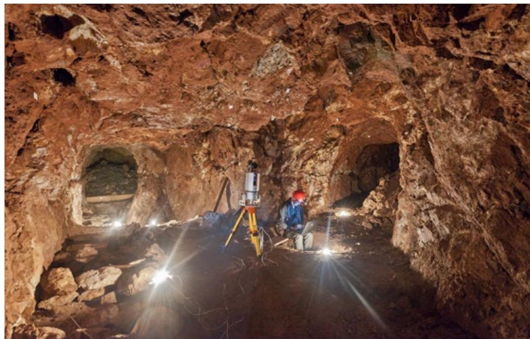
Im Goldbergwerk von Sakdrissi konnten 2011 zahlreiche Arbeiten in Bereich der Pinge A abgeschlossen werden; zusammen mit der Fa. ArcTron, M. Schaich, konnten große Teile des Grubenbaues mit Hilfe eines Laserscanners aufgenommen werden
